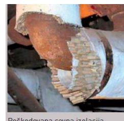
Poškodovana cevna izolacija
